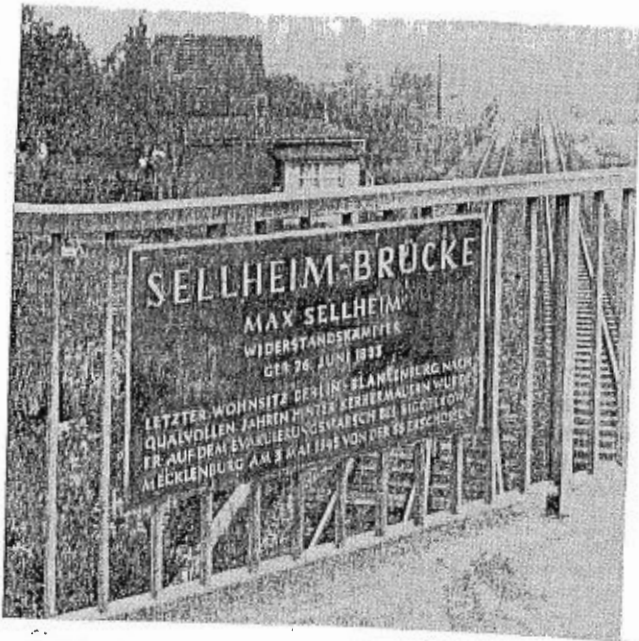
Auf der Sellheimbrücke
